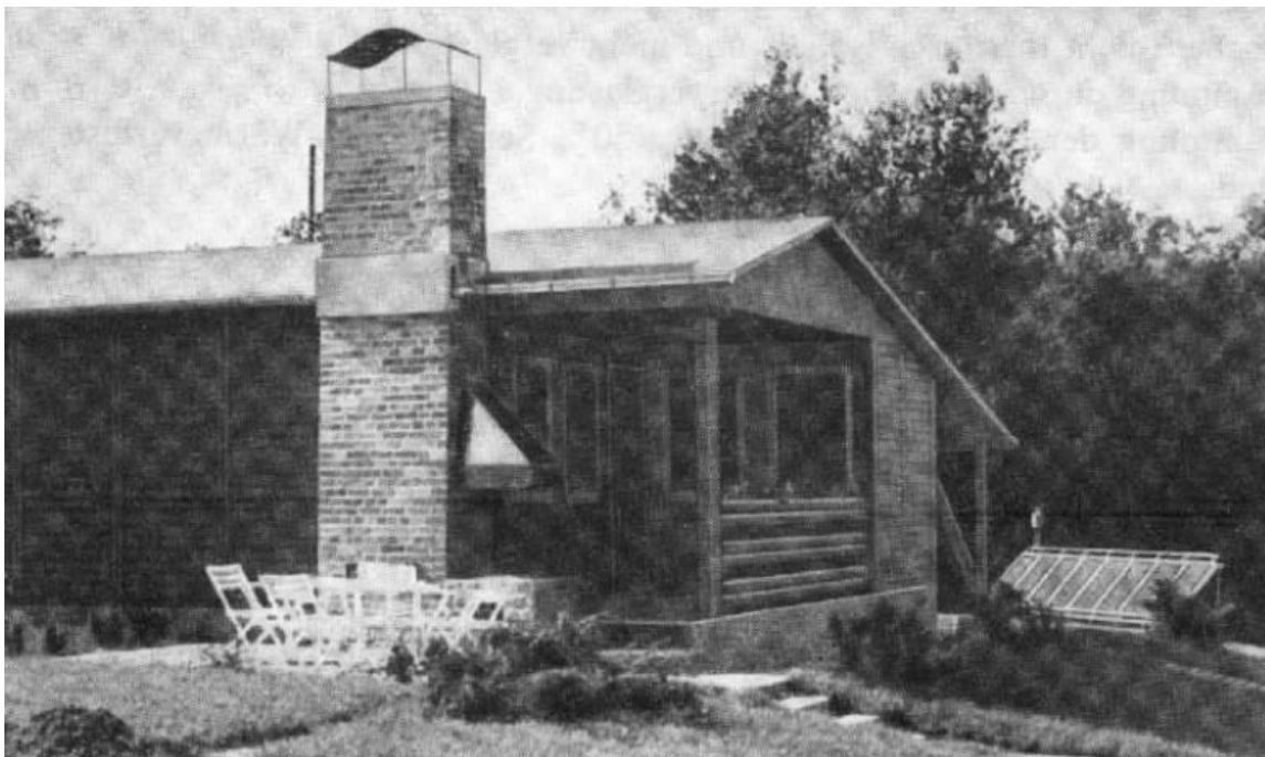
Blockhaus Rinkermühle/Harz Luft-Wasser (10 KW/1979)
