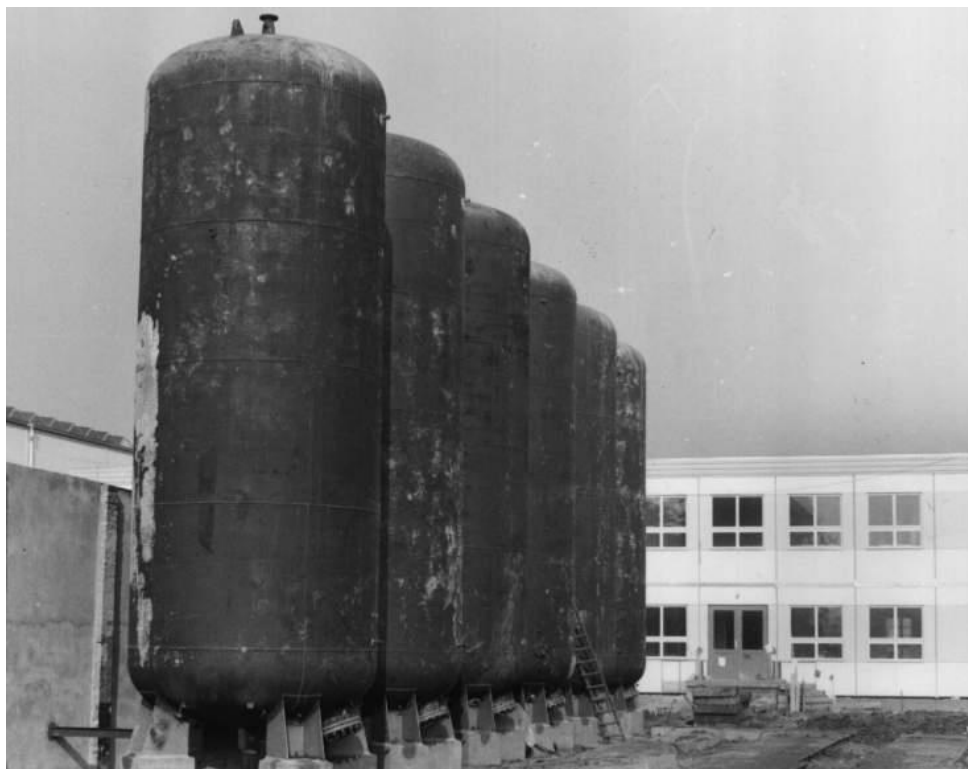
Speicher im Bau Experimentalbau ILK
