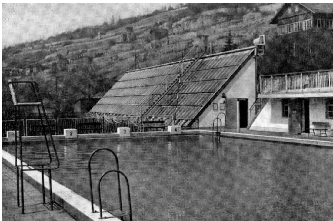
Freibad Freyburg/Unstrut Quelle: Solarkollektoren (120 KW/1979)
