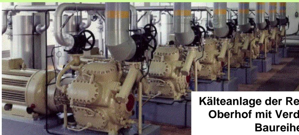
**Kälteanlage der Rennrodelbahn Oberhof mit Verdichtern der Baureihe 2**
