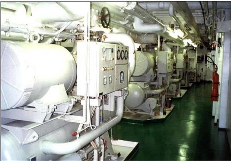
Schraubenverdichter als Kältemaschinen im MR eines Kühlschiffes, Quelle Dr.-Karl-Heinz Hochhaus -
