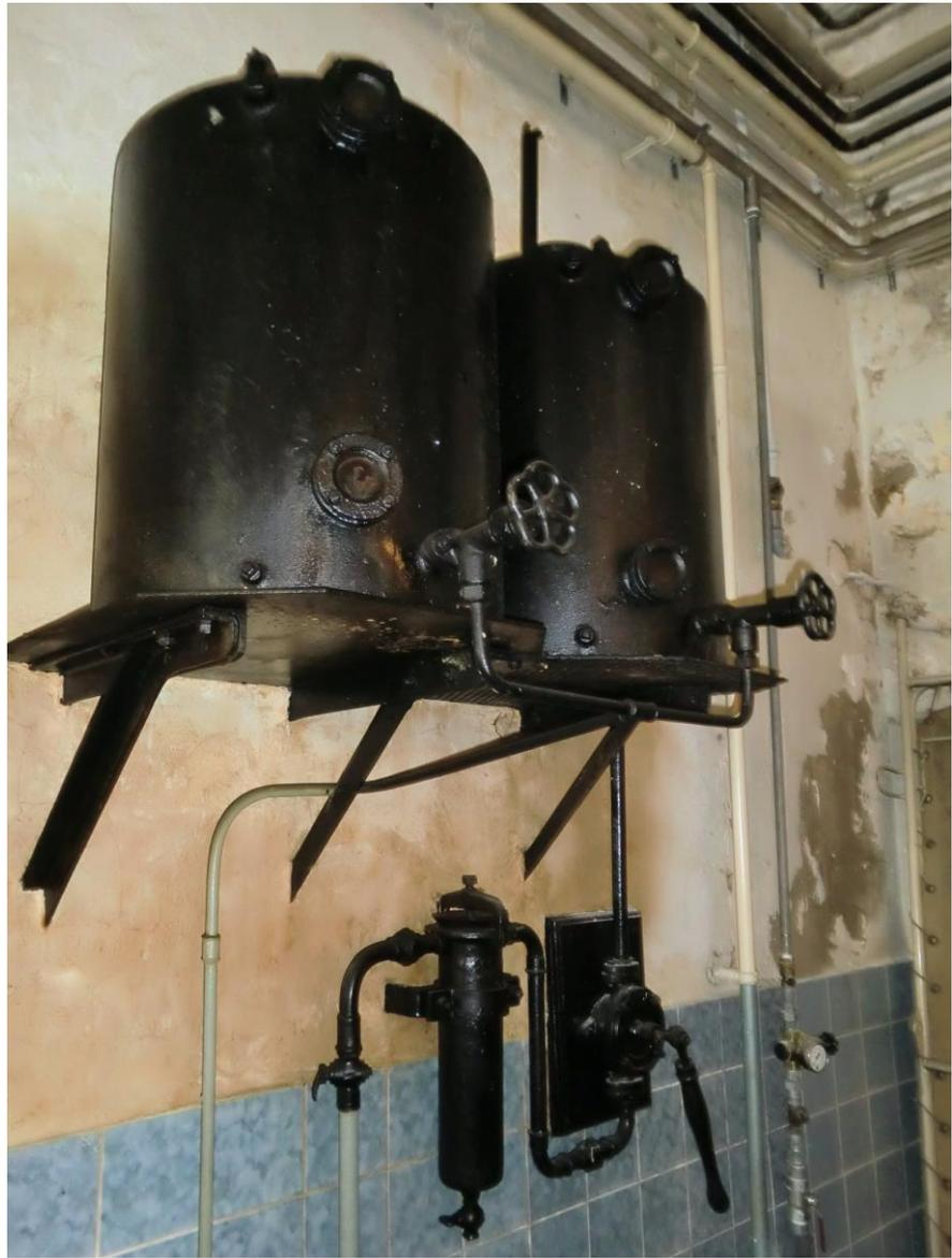
Auch andere Elemente der Anlage wie Ölseparatoren und Schalttafel sind noch im Original erhalten
