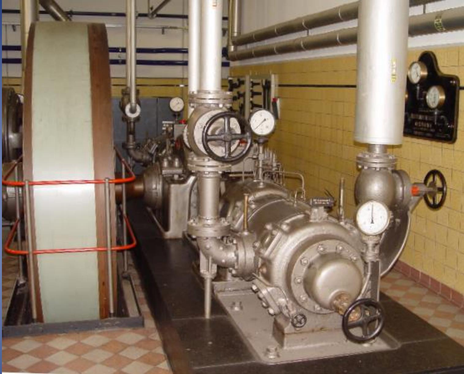
Verdichter System Linde, Hersteller Maschinenfabrik Esslingen,
