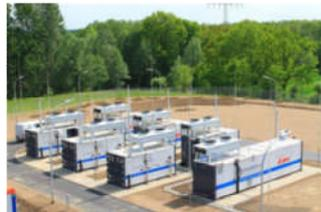
Die Anlage elektrolysiert mit der Energie von Windkraftanlagen Wasser in Wasserstoff. Der Wasserstoff wird in das Erdgasnetz eingespeist.
