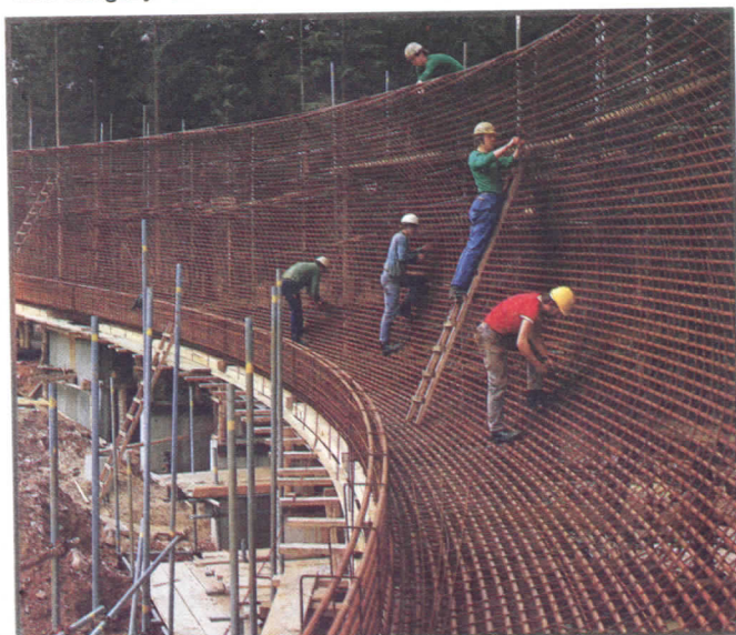
Bob- und Rennschlittenbahn Altenberg/DDR Rohrmontage in einer Kurve
