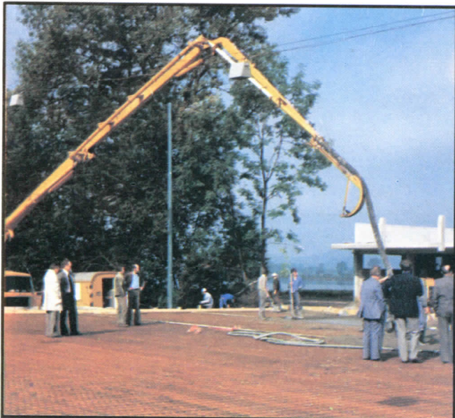
Betonieren der Freilufteisbahn in Seewen/Schweiz
