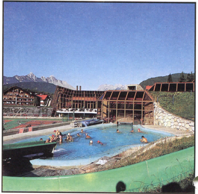
Sport- und Kongreßzentrum Seefeld/Österreich Freibad und Schwimmhalle werden mit Abwärme aus dem Kälteerzeugungssystem beheizt.
