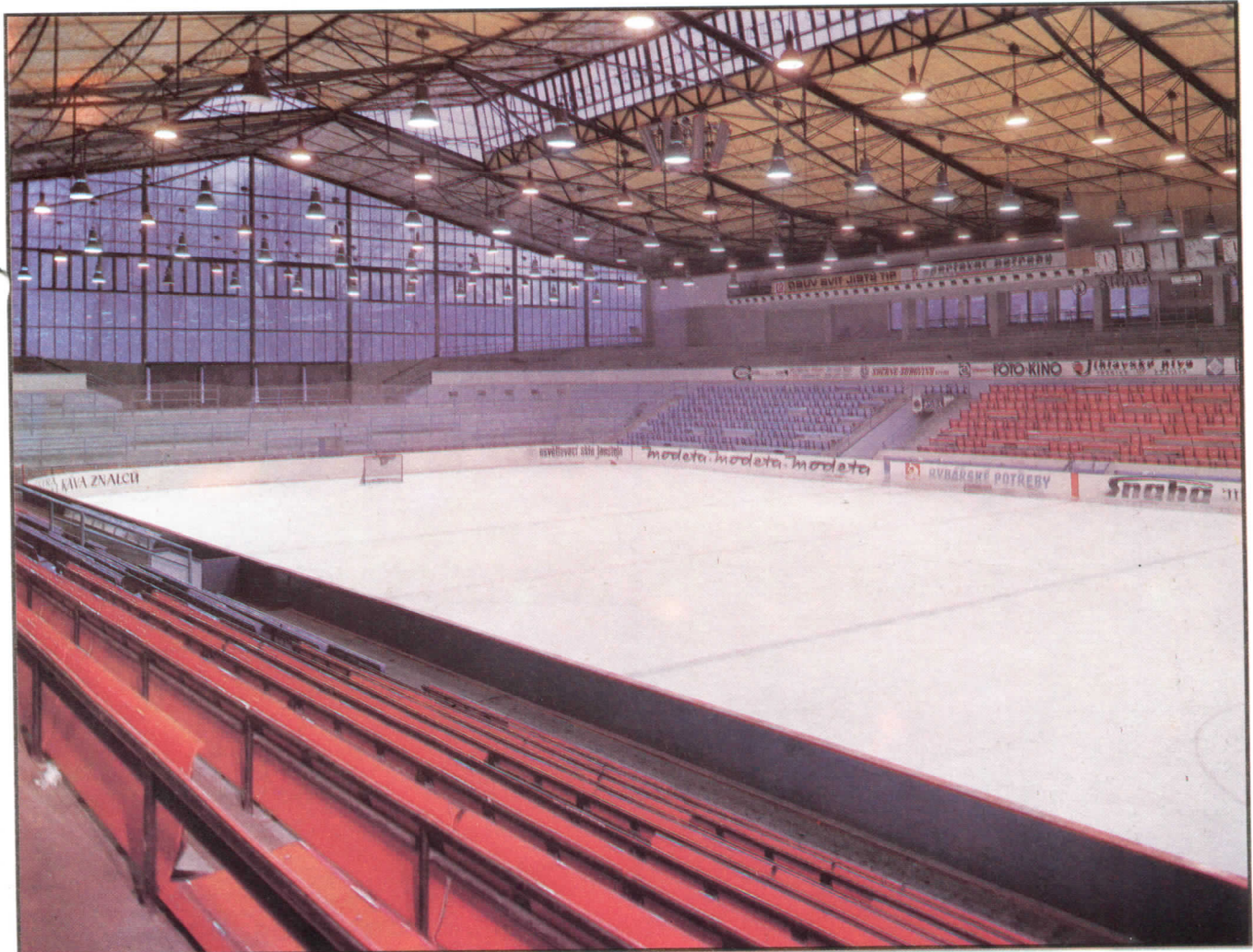
Eissporthalle in Jihlava/CSSR
