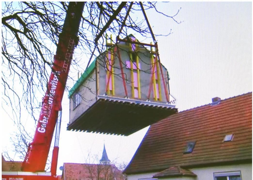
Dann wurde das 110 to. Schwere Gebäude mit dem Kran angehoben, z.T. über ein Nachbarhaus gehieft und anschließend auf einem Tieflader abgesetzt.
