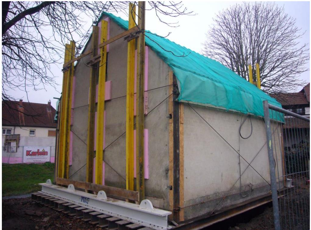
Zuerst musste das Kühlhaus vom Fundament gelöst, ein neues Fundament aus stabilen Stahlträgern untergebaut, Befestigungspunkte für den Kran angebracht und das Gebäude stabil verpackt werden.
