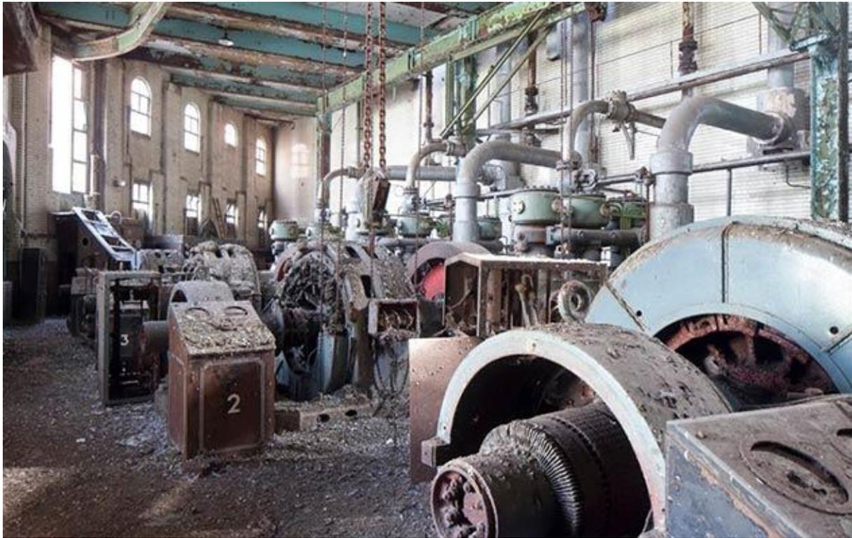
Heutige Zustand der Anlage: die gewaltigen Verdichter nebst Rohrleitungen sind noch original – die Kupferwicklungen der Antriebsmotoren wurden allerdings entfernt!
