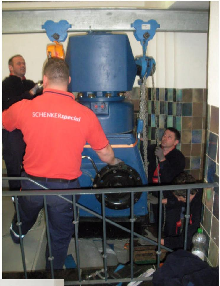
**Transport über eine schmale Treppe – der Treppenunterbau wird sicherheitshalber um jeweils zwei Stufen verlegt**
