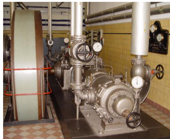
Der Antrieb erfolgt durch eine Dampf- maschine mit 475 PS, Hersteller MAN AG, Nr. 5135, Baujahr 1939
