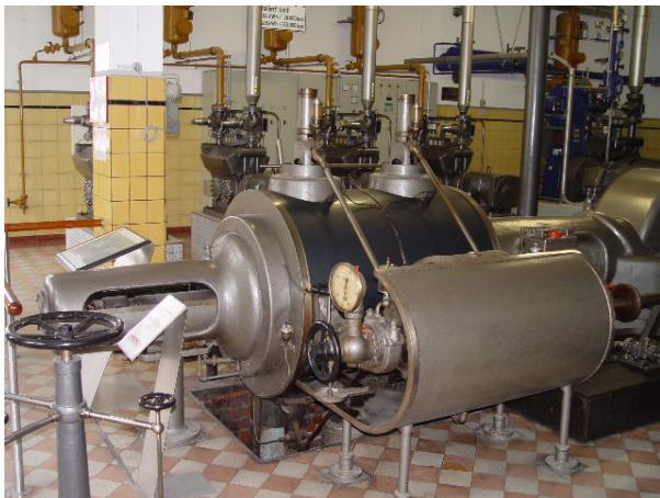
Verdichter System Linde, Hersteller Maschinenfabrik Esslingen, Type 2/40L400, Baujahr 1939, Verdichter, 1-stufig, doppelwirkend, Kältemittel NH 3
