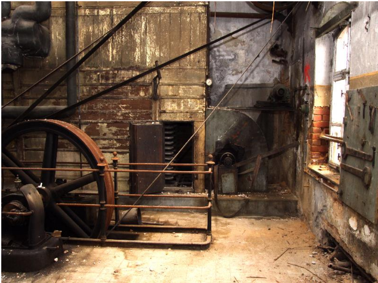
Eingehauster Querrohrverdampfer mit Radiallüfter
