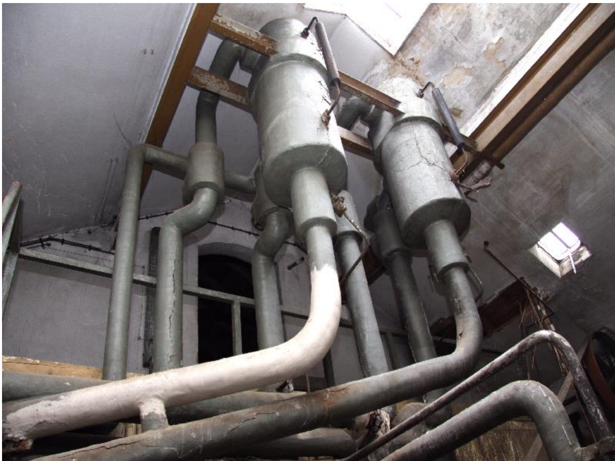
Saugseitige Abscheider mit Standrohranzeige
