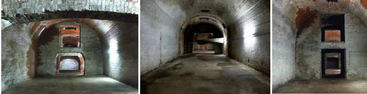
Der Keller ist aus einzelnen Ziegeln Viel Platz für Bierfässer und Eis gemauert
