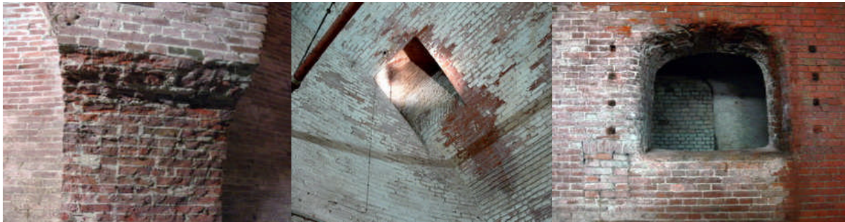
Enorme Statik durch dicke Wände Reste eines Transportsystems Fenster zum nächsten Quergang
